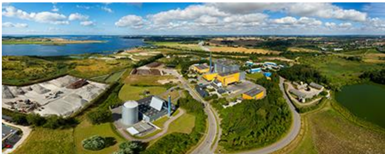
Figur 5-1 AffaldPlus anlæg i Næstved (Foto udlånt af AffaldPlus).
